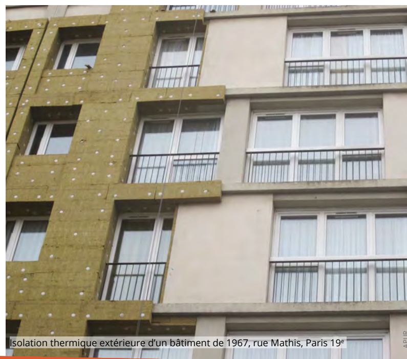
Isolation thermique extérieure d'un bâtiment de 1967, quai de Metz, Paris 19 e
